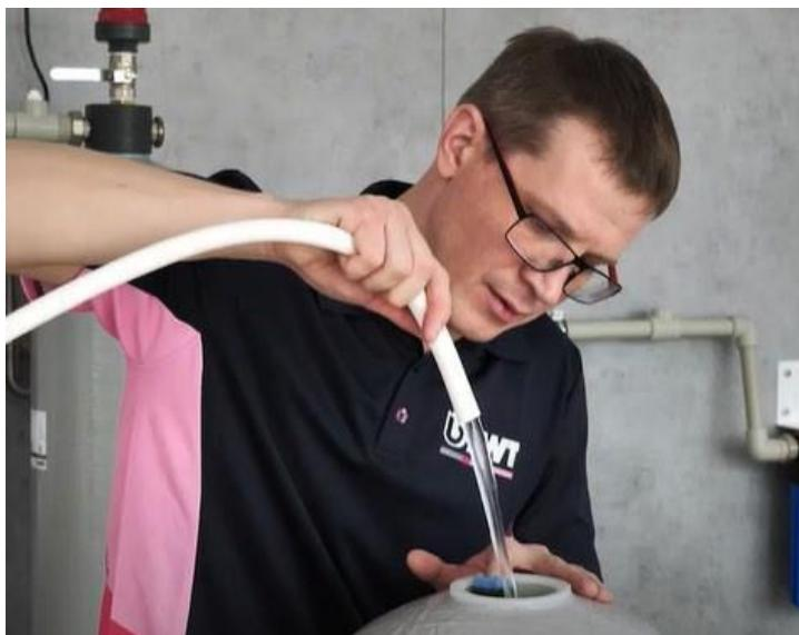
Заполнить корпус установки водой приблизительно на 1/4 объема. Вода будет служить буфером при засыпке ионообменной смолы.
