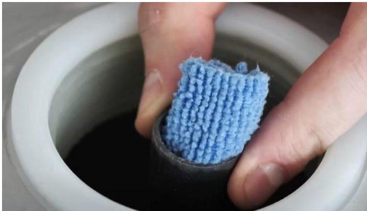
Закрыть верхнее отверстие водоподъемной трубы плотной пробкой из любого материала так, чтобы ни при каких условиях эта пробка не могла провалиться внутрь трубы.
