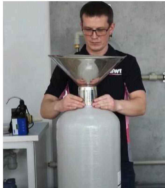
Установить в горловину корпуса воронку. Водоподъемная труба при этом может немного отклоняться от вертикали, но нижнее дренажное устройство не должно выходить из своего посадочного места на дне корпуса.
