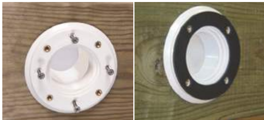
Рисунок 24 – Монтаж корпуса возвратной форсунки и уплотнения
