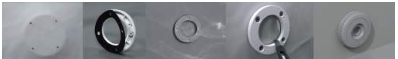
Рисунок 35 – Установка фланца на возвратной форсунке
