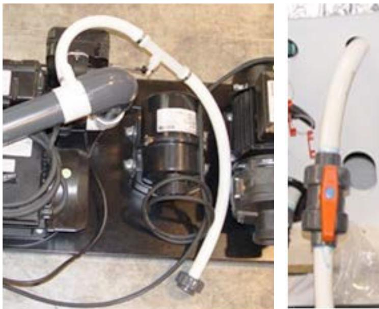
Контур, направляющий газообразный озон от озонатора к тройнику Вентури, включает гибкую белую трубку из ПВХ диаметром 7 мм, которая описывает петлю под чашей спа, но над линией воды, чтобы препятствовать перетеканию воды обратно в озонатор. Оба конца этой петли выступают из монтажной платы блока технического оборудования. Один конец соединяется с тройником Вентури, а другой – с озонатором.
