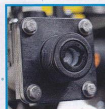
**Патрубки для подключения Bewamat снабжены обратными клапанами, препятствующими обратному току воды**
