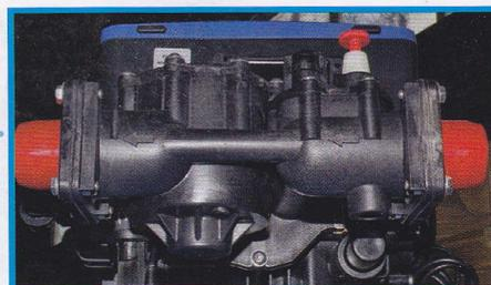
**Через байпас к умягченной воде подмешивают исходную воду, регулируя ее объем с помощью вентиля**
