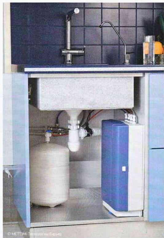
▲ Фильтр «Аквафор Модерн» присоединяется к крану при помощи дивертора
